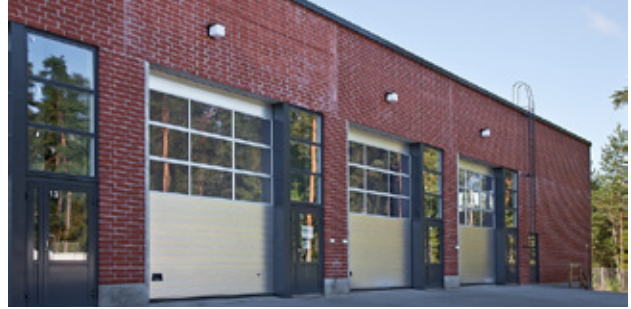
Kuva 2: Drive-in-Center Koskelo, Espoo
