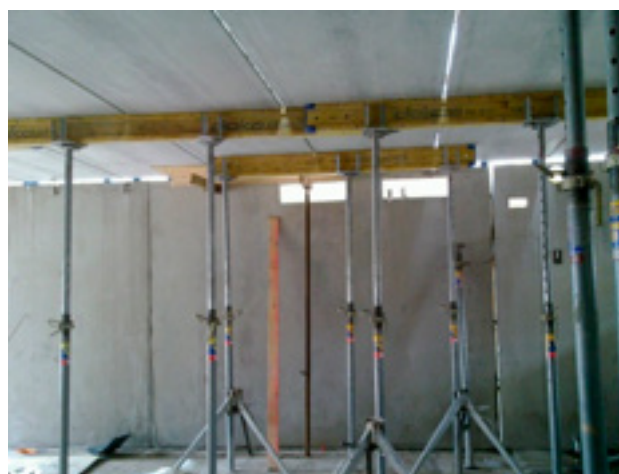
Kuva 12: Kuorilaattojen työnaikainen tuenta
