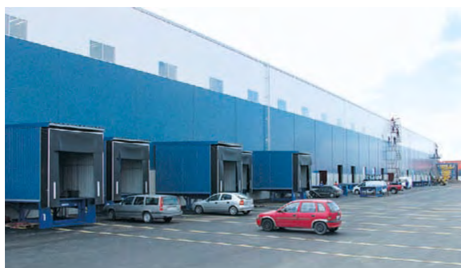
Stevecolle rakennetussa Kotkan konttiterminaalissa on toteutettu todella avarat tilat käyttäen TEK-laattoja ja HI-palkkeja 24 m x 21,6 m pilariruudulla.
